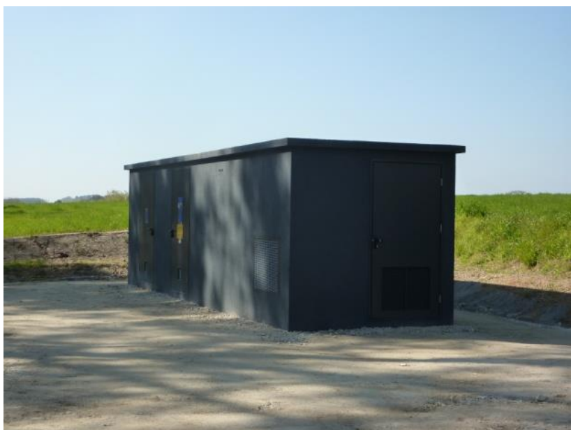
Figure 19. Aperçu du type de poste de livraison (Crédit photo : Quénéa)
