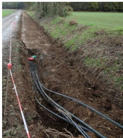
Figure 18. Enfouissement de câbles (Crédit photo : Quénéa)
